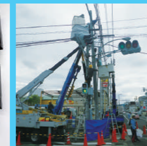
県警信号工事
